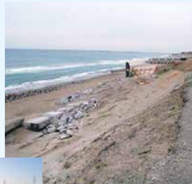
海岸災害復旧事業 御前崎市白羽地先
