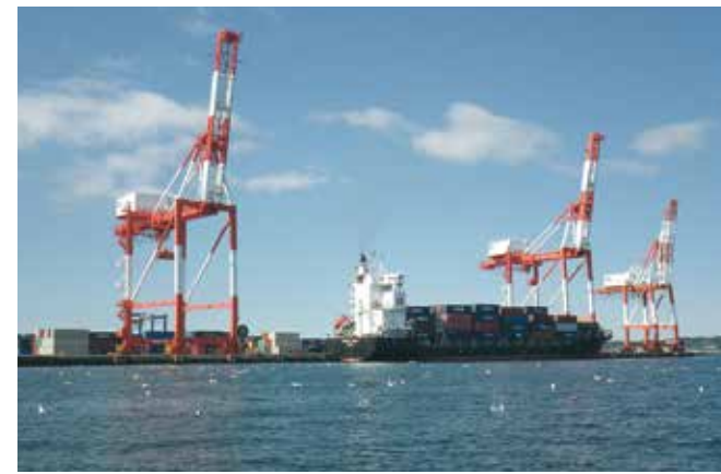
御前崎港内航船荷役
