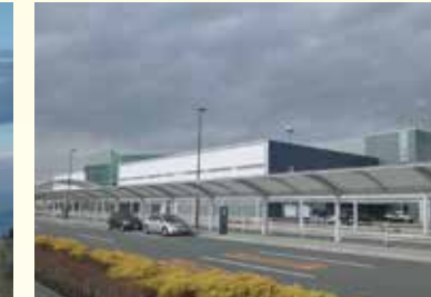
富士山静岡空港旅客ターミナルビル
