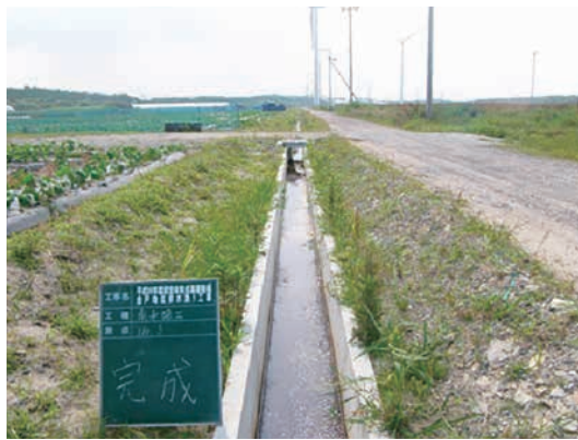
排水路工(合戸地区)
