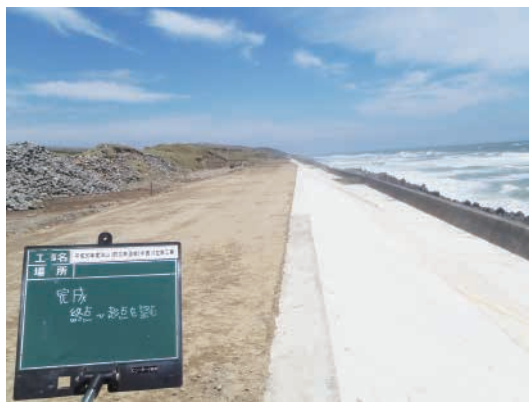
海岸防潮堤整備(御前崎市白羽)
