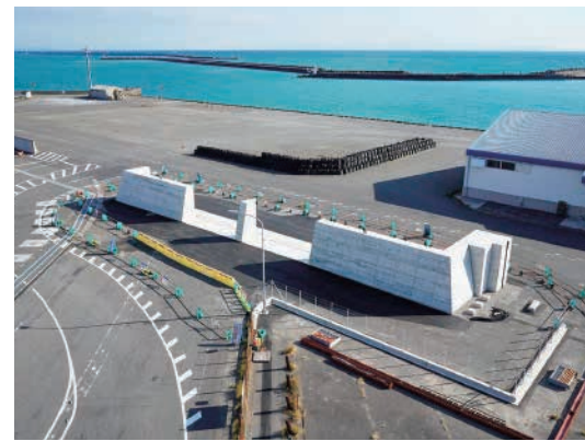
御前崎港防潮堤整備
