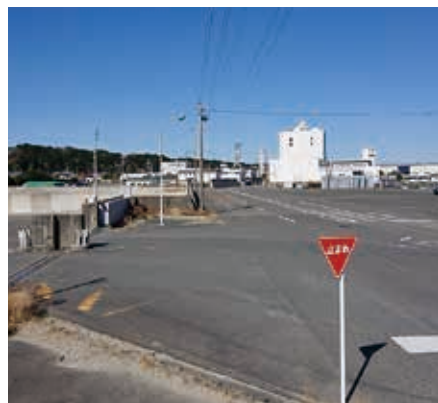
御前崎港高潮対策
